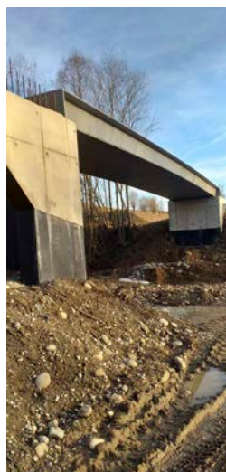
Kładka pieszo jezdna na potoku Mizerzanka
